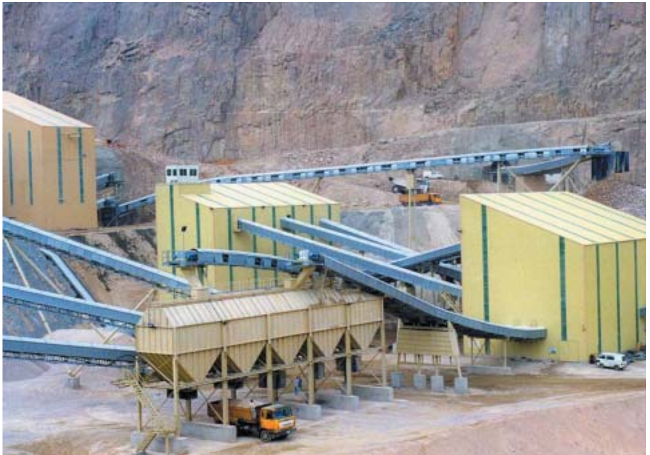
1400 mètres de transporteurs à Hong Kong
