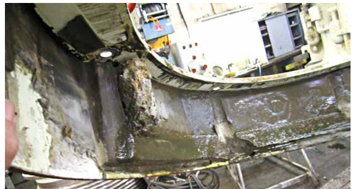
Intérieur d'un blindage de balourd colmaté.
