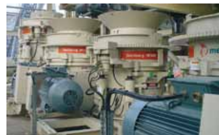
Instalação fixa : Um HP500, um HP300, dois HP200 britando "anfíbolito".
